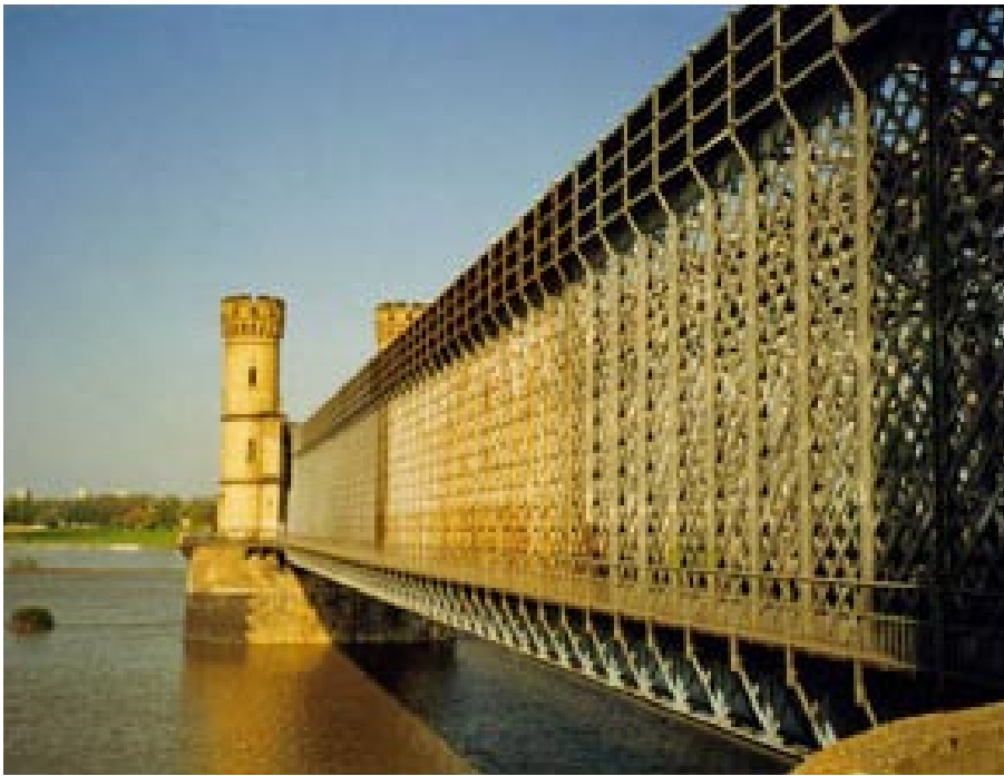
Rys. 1. Fragment historycznego mostu w Tczewie
